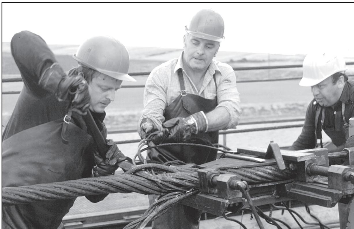
Fig. 34: Réalisation d'une épissure
